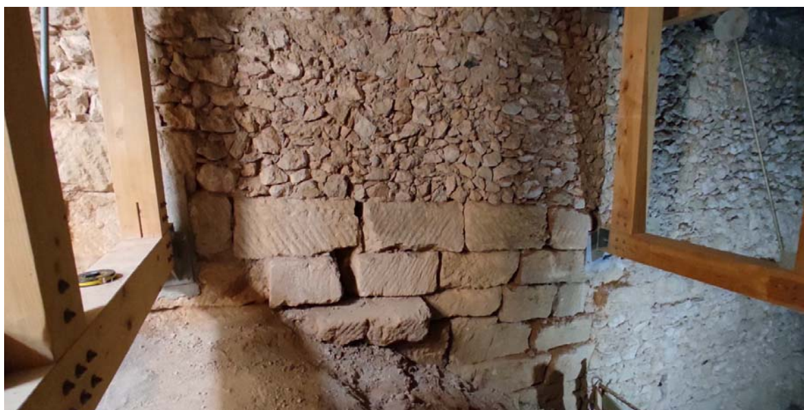
Imatge 26. Fotografia que mostra la diferència de nivells del farciment del tram buidat l'any 2016 i el del l'ensulsida de 1936.
