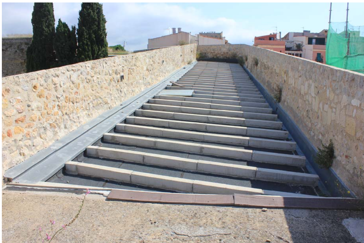
Imatge 6. Estat inacabat del paviment del sector del pas de ronda executat a l'any 2016 (tram superior present actuació).
