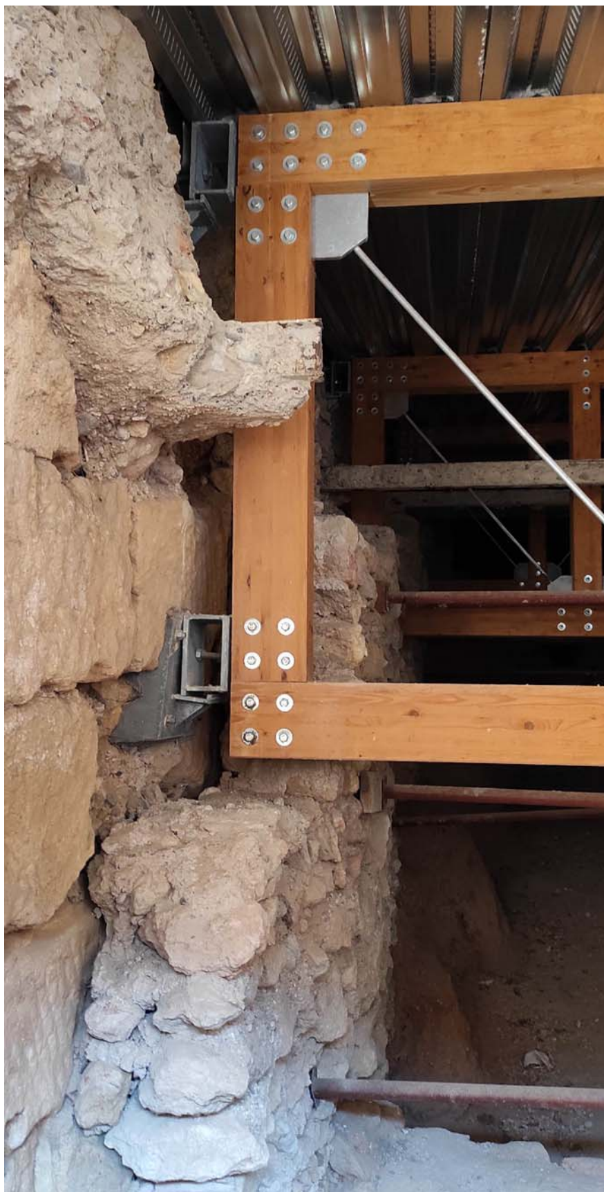
Imatge 17. Detall de recolzament d'encavallades de fusta i estintolament de murs amb precària estabilitat estructural a l'interior del tram de muralla buidat l'any 2010.
