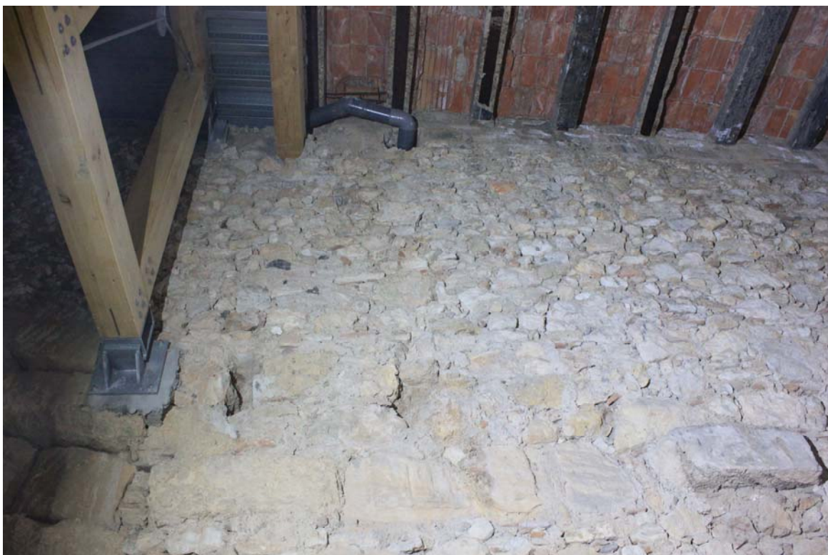
Imatge 23. Transició entre els trams centrals i superior amb cobriments realitzats respectivament els anys 1942 i 2016.
