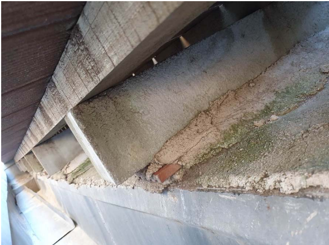
Imatge 8. Detall de la substrucció amb murets de formigó prefabricat i llistons de fusta del mateix tram.
