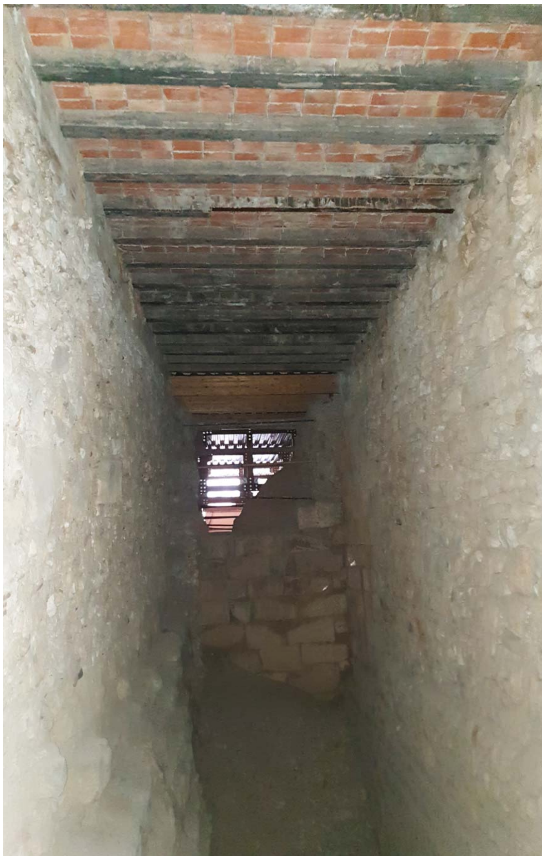
Imatge 20. Vista general del tram central de la muralla amb el buidat interior corresponent a l'esllavissada de l'any 1936.
