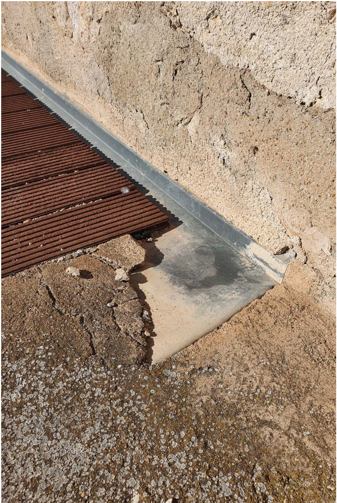
Imatge 9. Detall del minvell de planxa de zinc en l'encontre del paviment del tram inferior amb el parapet de fàbrica.
