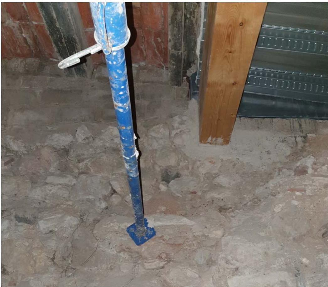
Imatge 19. Detall de la mateixa zona amb encastament de la darrera biga del primer tram i puntal d'estintolament dels murs interiors.
