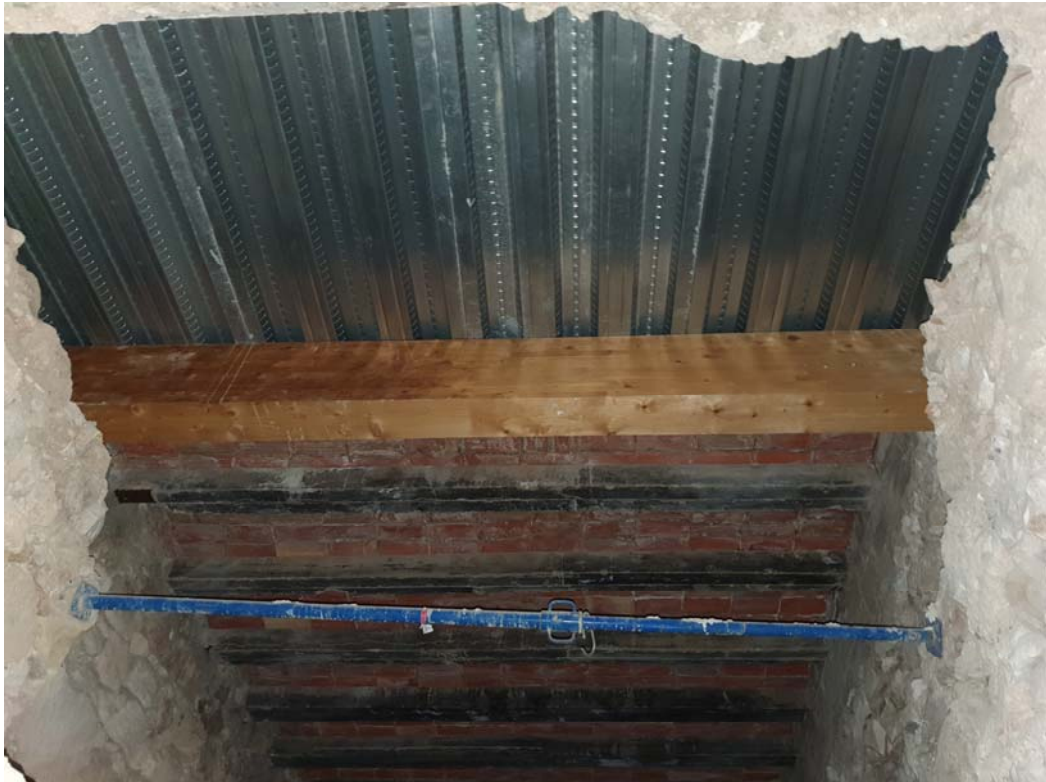
Imatge 18. Transició entre els sostres del pas de ronda de la muralla executats el 2010 i 1942.
