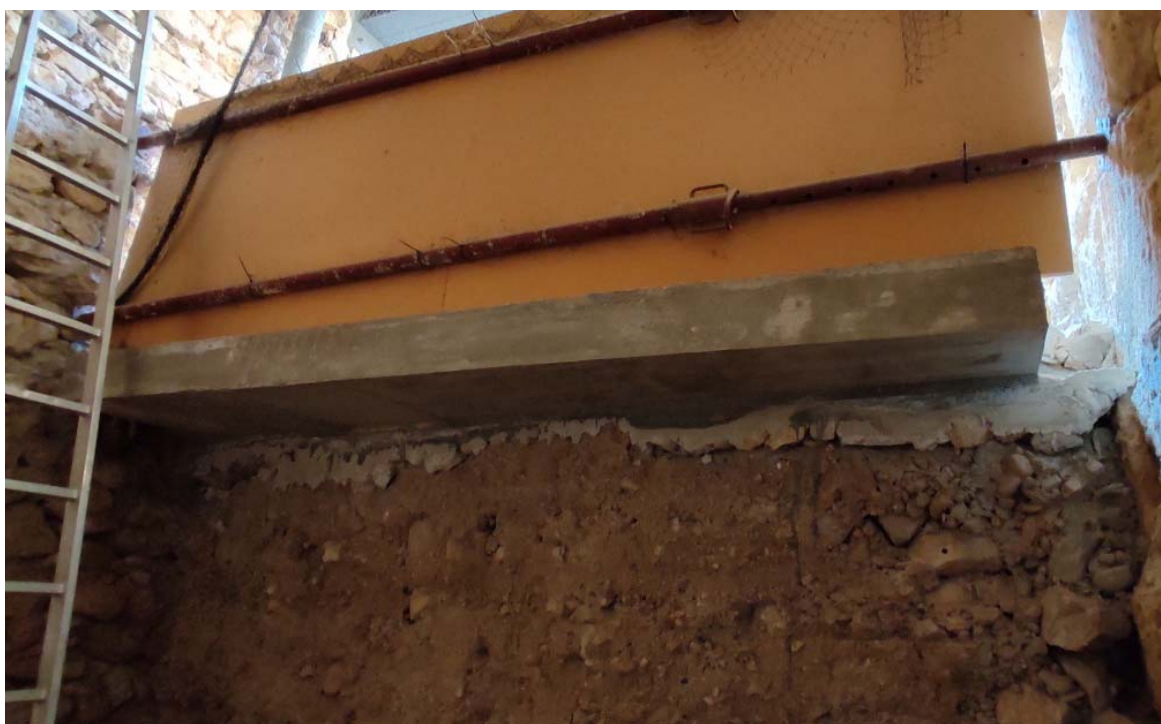
Imatge 15. Aspecte de la precària connexió actual existent entre l'escala d'accés al pas de ronda i l'espai interior buidat en l'actuació de l'any 2010.
