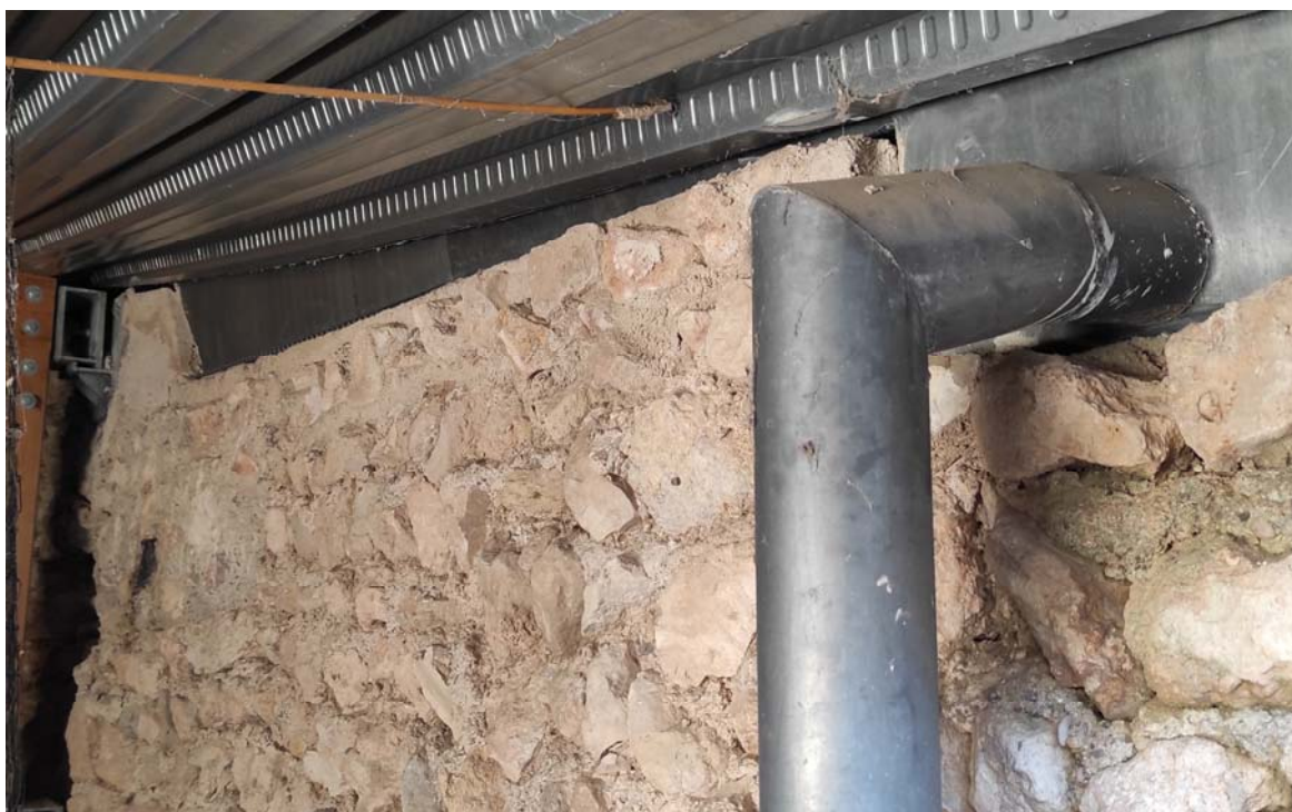
Imatge 16 Detall de connexió de baixant amb canal d'evacuació d'aigües pluvials corresponents al tram inferior del pas de ronda inclòs en el present projecte.
