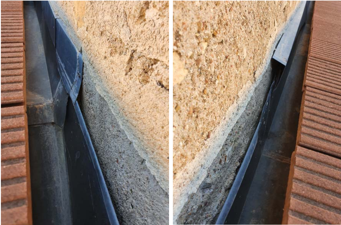
Imatges 7 i 8. Detalls dels desperfectes que presenta actualment el canal lateral del tram del pas de ronda realitzat al 2010.
