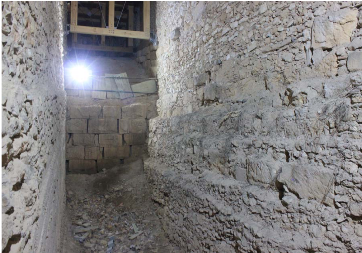
Imatge 21. Detall de l'extrem oriental d'aquell espai, amb la contenció provisional de les terres de buidat fet al tram superior.
