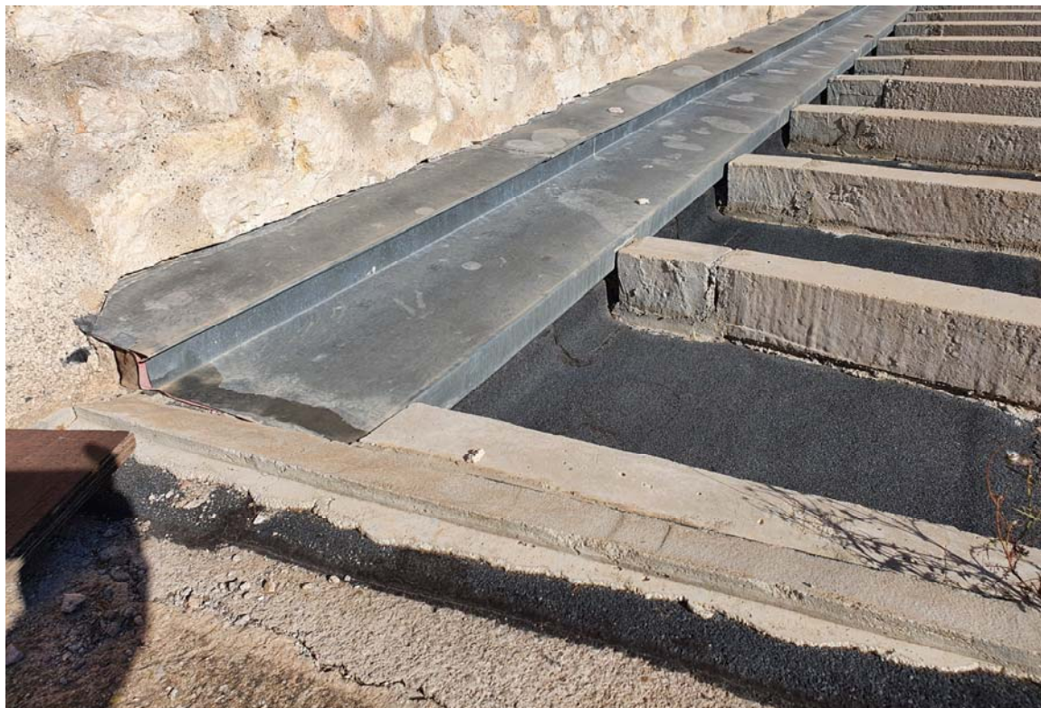
Imatge 10. Vista que mostra la composició del minvell previst per l'encontre de l'inacabat tram superior amb el parapet lateral.
