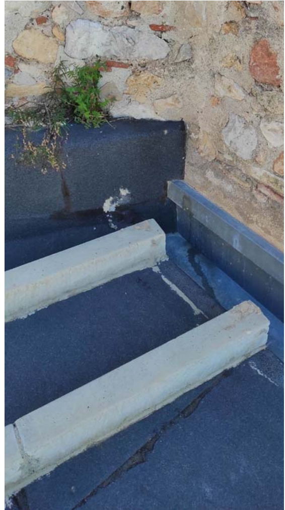
Imatge 12. Detalls de trapa d'accés a l'interior del a muralla i extrem superior del tram inacabat de pas de ronda corresponent a l'actuació de 2016.
