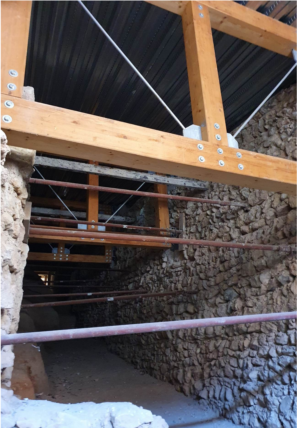
Imatge 14. Aspecte actual de la part buidat de l'interior de la muralla amb encavallades de fusta i puntals per evitar la bolcada dels murs de reforç interior de fàbrica de maçoneria.
