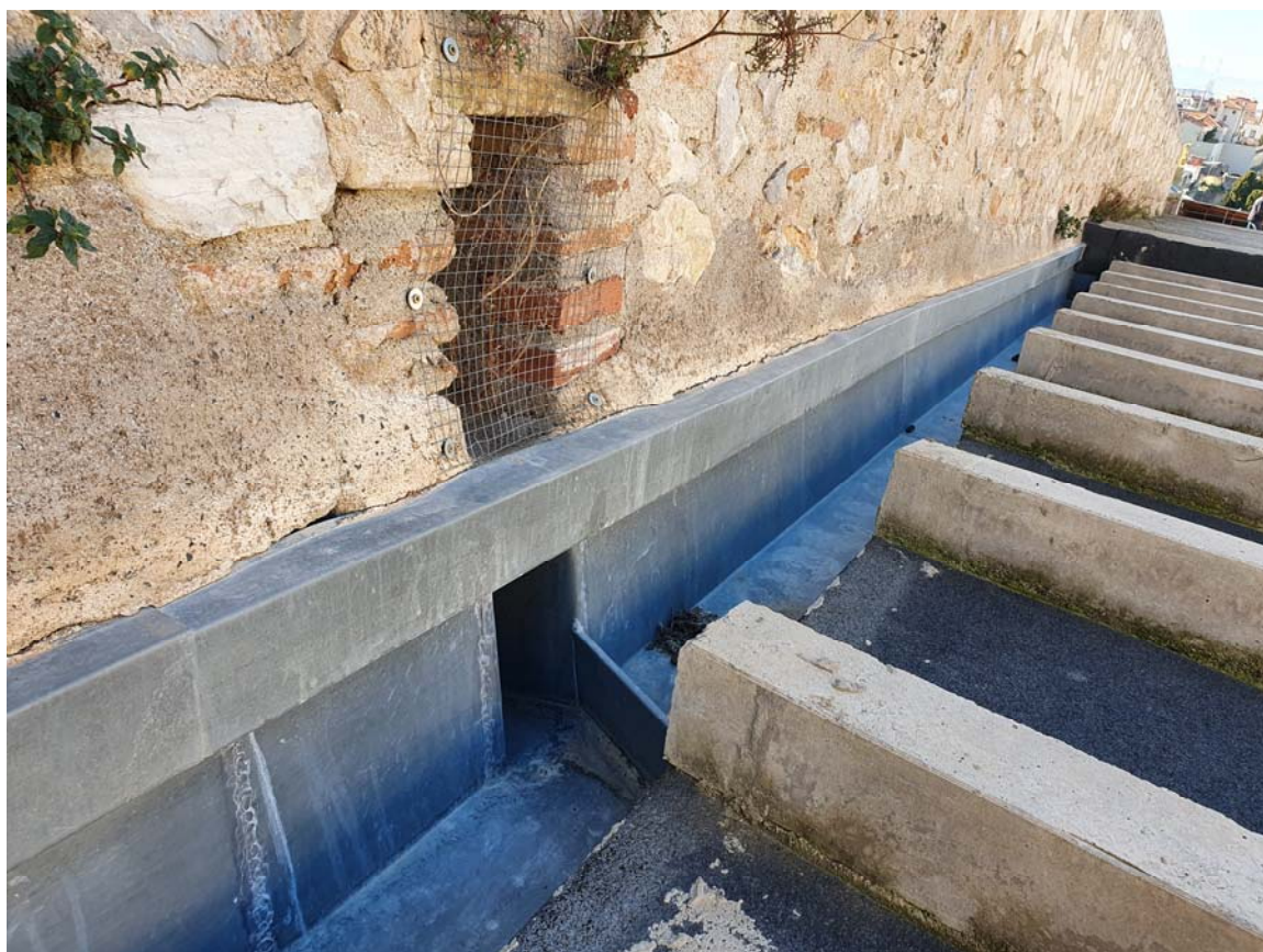
Imatge 11. Aspecte del canal lateral de recollida d'aigua executat en el mateix tram del pas de ronda.
