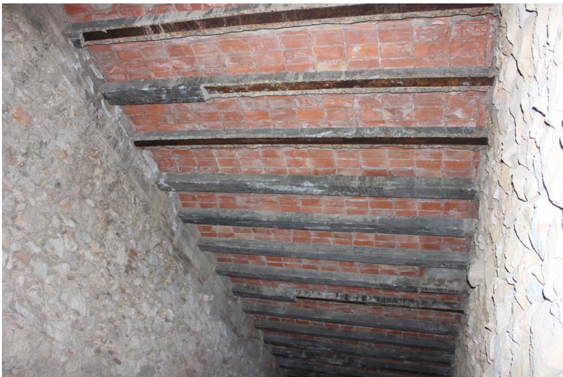
Imatge 24. Estat precari del sostre executat l'any 1942 amb biguetes d'acer (actualment oxidades) revestides de formigó.
