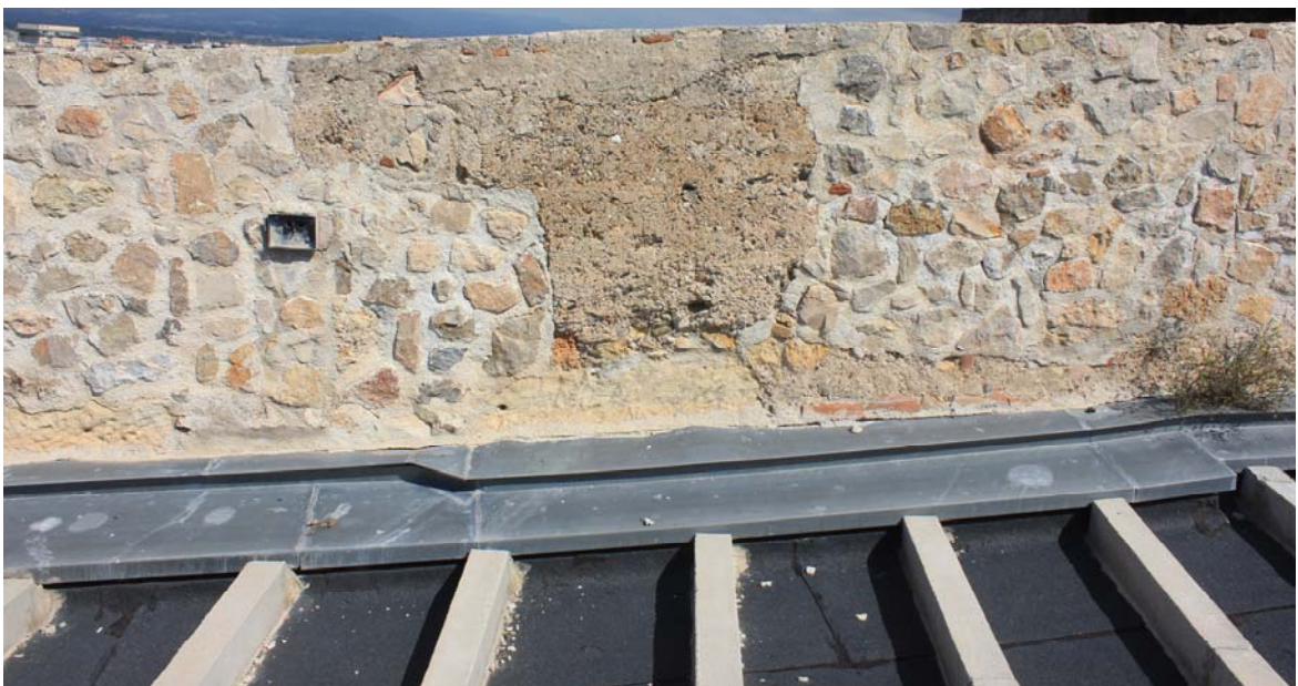
Imatge 13. Vista dels murets de substrucció d'aquest tram i del minvell de planxa previst per a resoldre el lliurament del paviment no col·locat amb el parament vertical del parapet lateral.
